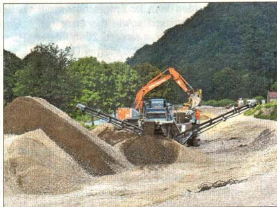
Viel Erde wird derzeit beim Ottiliensteg bewegt.
